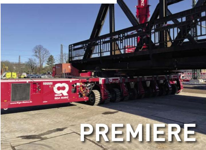
EINSATZORT: DARMSTADT → EQUIPMENT: LTM 1650-8.1 MIT 165T BALLAST - LTM 1500-8.1 MIT 165T BALLAST - LTM1450-8.1 MIT 134T BALLAST → SCHWERSTES EINZELTEIL: 160 T → ABMESSUNGEN: 40 M X 5,5 M X 13,7 M → EINSATZBESCHREIBUNG: AUSHEBEN ZWEIER DENKMALGESCHÜTZTER BRÜCKEN
