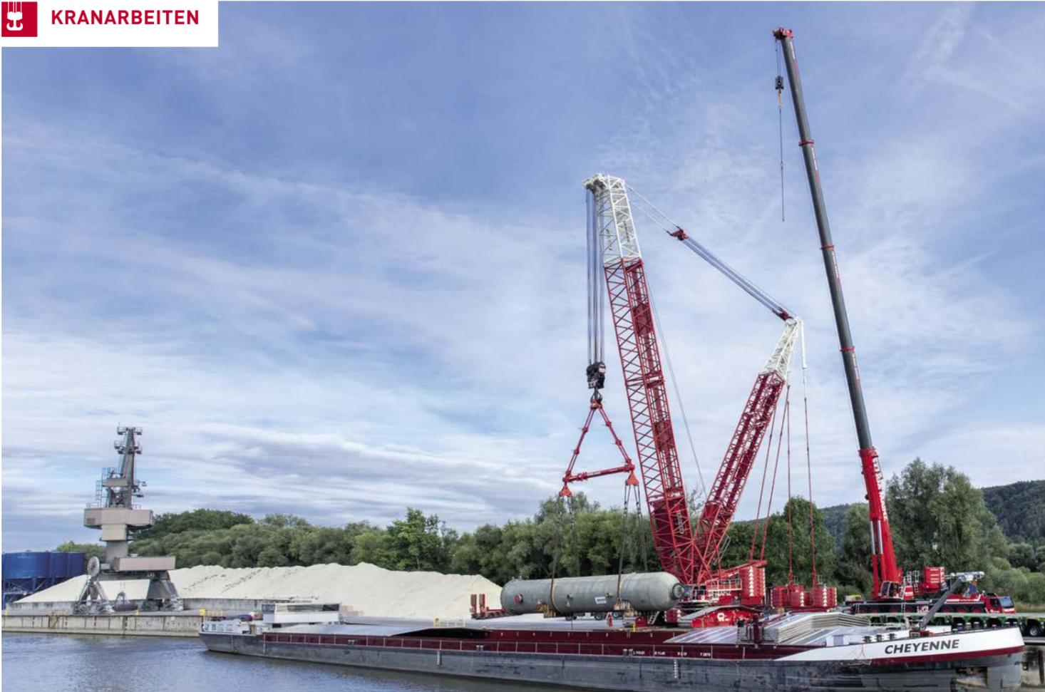
EINSATZORT: KELHEIM (ENTLADUNG) – NEUSTADT AN DER DONAU (EINBAU) → EQUIPMENT: LR 1600/2 MIT 54M HAUPTAUSLEGER 65T ZENTRALBALLAST 150T DREHBÜHNENBALLAST 250T SCHWEBEBALLAST - LTM1450-8.1 → SCHWERSTES EINZELTEIL: 339,3T → ABMESSUNGEN: 25,70M X 5,2M X 4,26M → EINSATZBESCHREIBUNG: ENTLADUNG EINER KOLONNE VOM SCHIFF ZUM STRASSENTRANSPORT UND AUFSTELLEN IN RAFFINERIE
