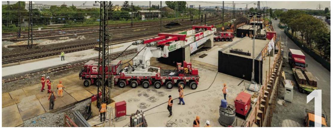
Der Brückenüberbau wird angehoben und befährt das mit Stahlplatten ausgelegte Nachbargleis
