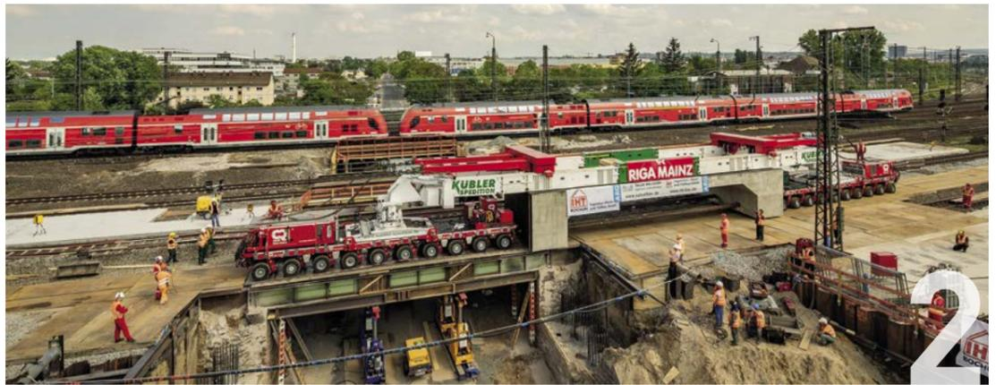
Zur Überquerung wurde die alte Brücke versteift um tragfähig zu sein
