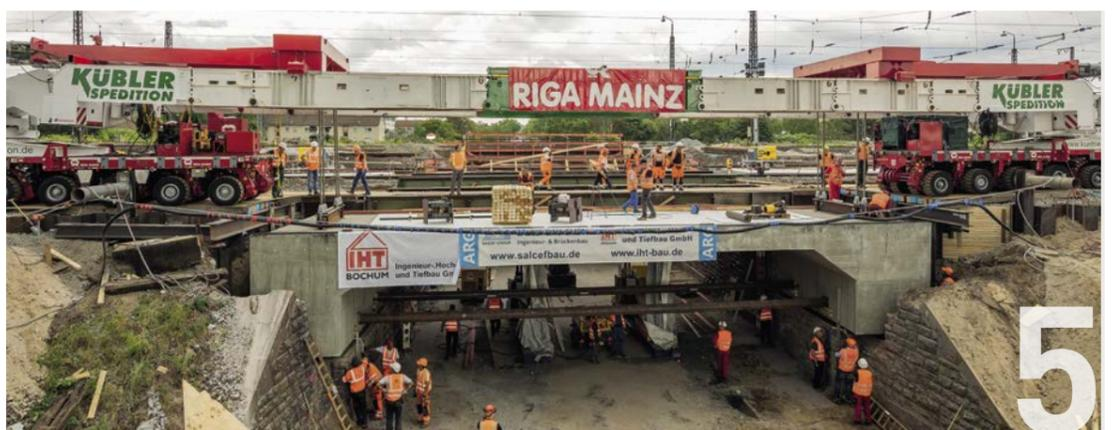
Die Endposition ist erreicht und die acht Tragseile können ausgehängt werden
