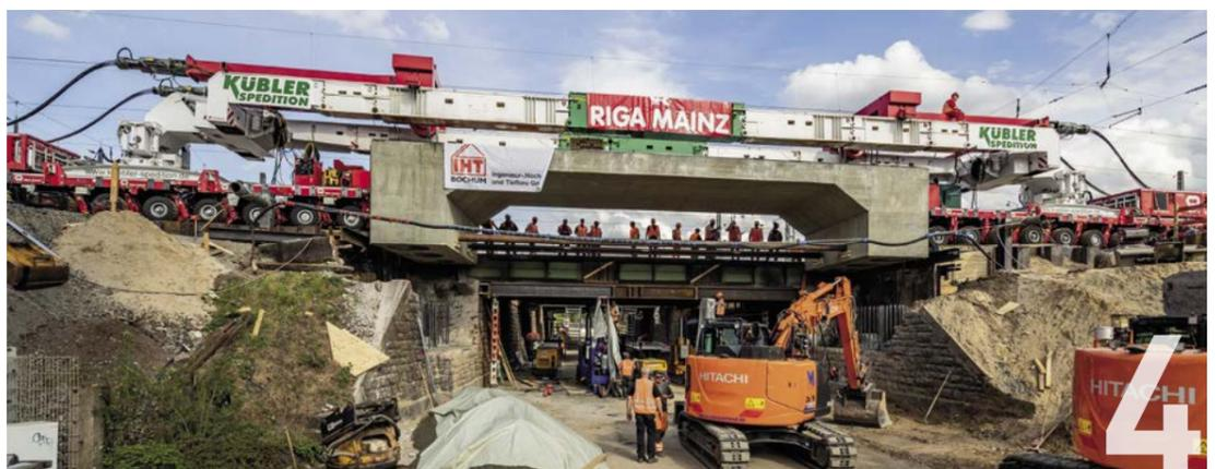
Der Neubau wird millimetergenau positioniert und mittels Litzenhebern abgelassen
