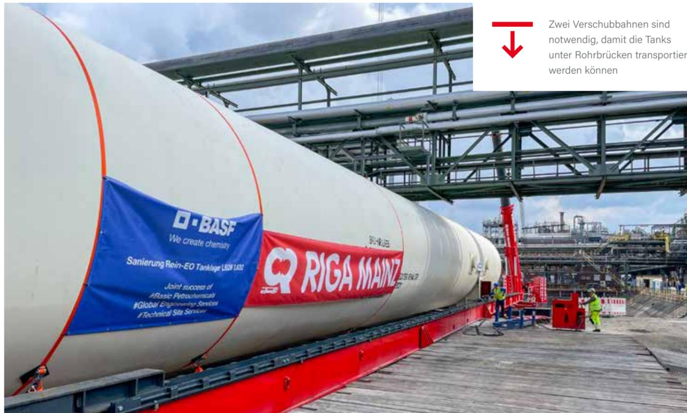
↓ Zwei Verschubbahnen sind notwendig, damit die Tanks unter Rohrbrücken transportiert werden können
