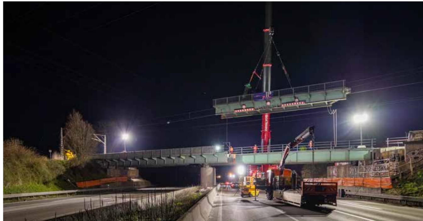
Eine stark beschädigte Brücke musste von unserer Mannschaft über der vielbefahrenen A5 in der Nähe des Nordwestkreuzes Frankfurt in einer Nacht demontiert und zur genaueren Überprüfung nach Koblenz transportiert werden. Spannend wurde der Aushub, da es bei älteren Bauteilen nur selten genauen Daten bezüglich des Gewichtes und Schwerpunktes gibt. Für den Hub wurde der LTM 1650-8.1 am Fahrbahnrand platziert und ein Kettengehänge mit speziellen Hebezügen eingesetzt. Die genietete Stahl-
