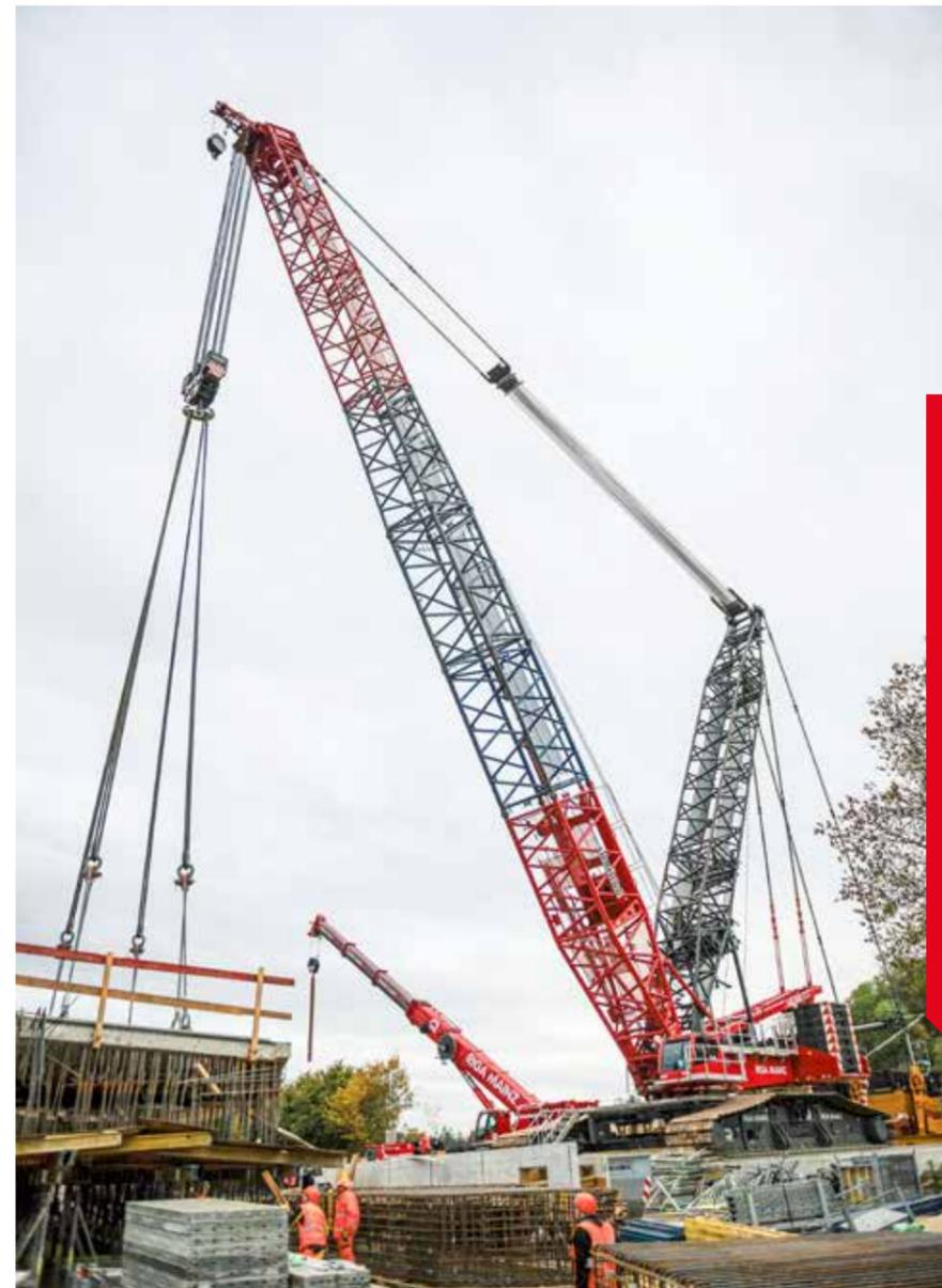
← Für den Standort des Raupenkranes wurde eine massive Betonplatte gegossen
