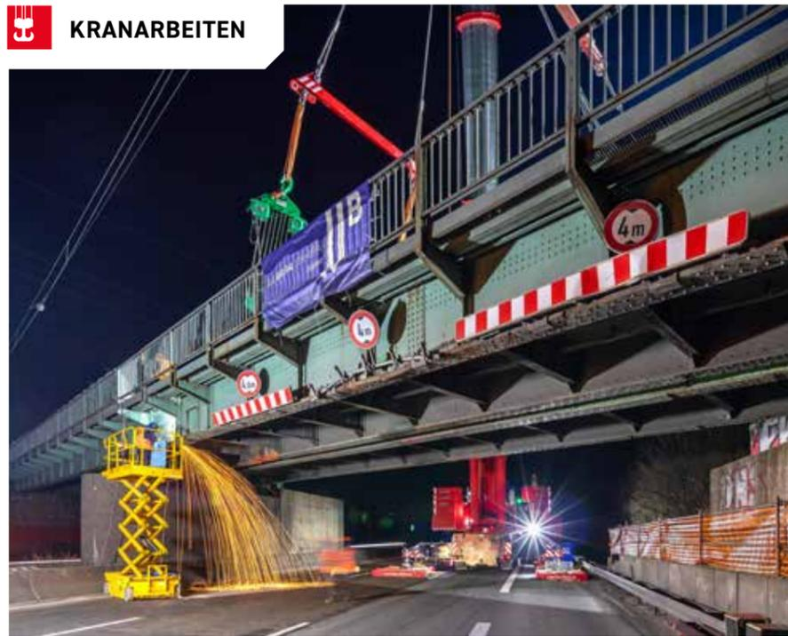
← Die Brücke ist angeschlagen und der Trennschnitt erfolgt
