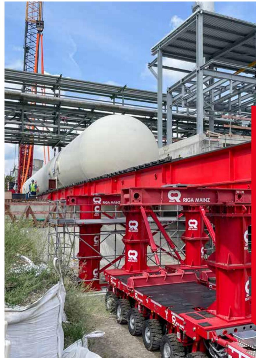
← Ein SPMT Modul mit aufgebautem Traggerüst übernimmt die Vorderseite der Tanks. Unten: Planzeichnung für die Übernahme der Last von der Verschubbahn
