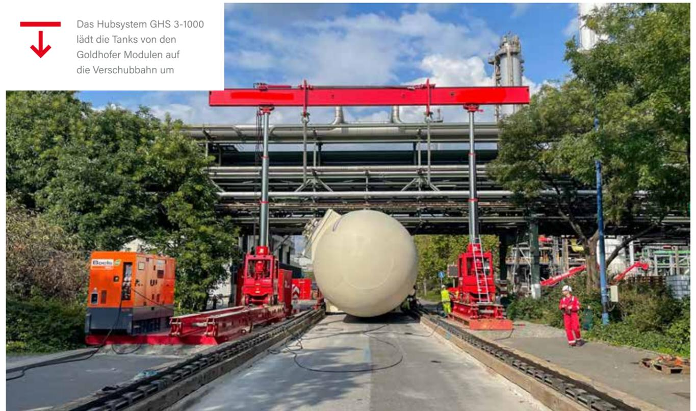
↓ Das Hubsystem GHS 3-1000 lädt die Tanks von den Goldhofer Modulen auf die Verschubbahn um
