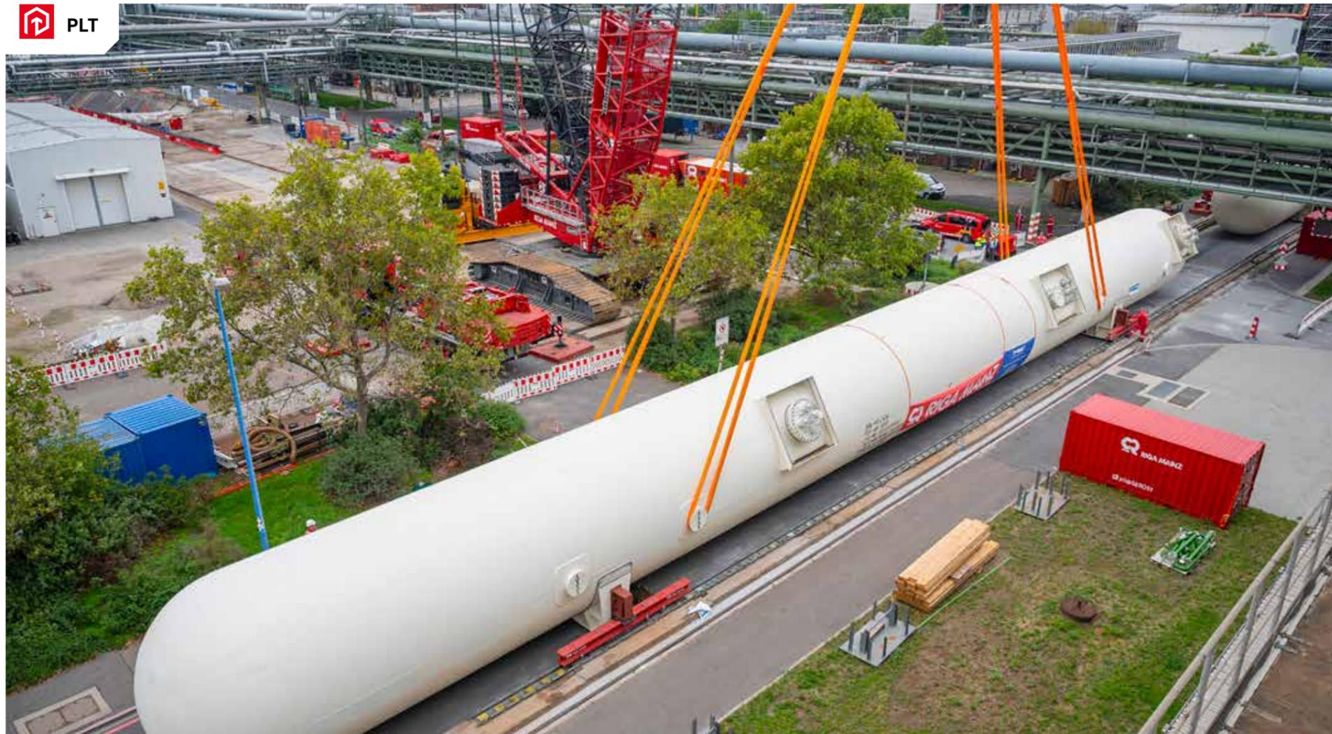
← Am Ende der ersten Verschubbahn dreht der Raupenkran die Last um 90 Grad
