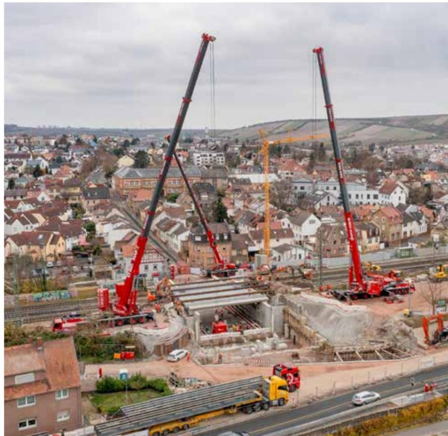
Gleichmäßig heben sich die Hakenflaschen des LTM 1650-8.1 und LTM 1450-8.1 zum Aushub der Hilfsbrücken parallel zur vielbefahrenen B9 in Nierstein am Rhein. Es ist die letzte von drei Modulbrücken, die ausgebaut werden mussten, um die neue, parallel zum Bestand errichtete Unterführung einschieben zu können. Die beiden Großkrane thronen auf zwei eigens aufgeschütteten und gut verdichteten Standplätzen links und rechts der Baugrube am Rhein.
